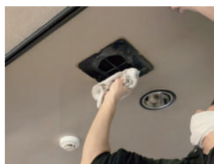
換気口の清掃
